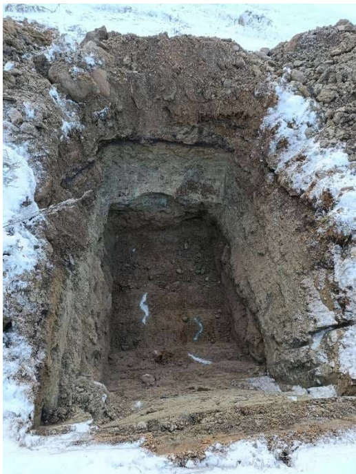
Kuva 3. Tutkimuspiste SW3. Tutkimuspisteessä ei havaittu mitään poikkeavaa. Kaivu päättyi isoon kiveen.
