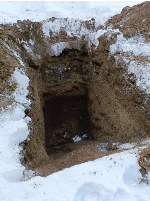
Kuva 2. Tutkimuspiste SW2. Tutkimuspisteessä ei havaittu mitään poikkeavaa.
